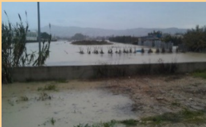
Rottura argine Tronto a Sant'Anna di Monteprandone (foto Sergio Loggi)
